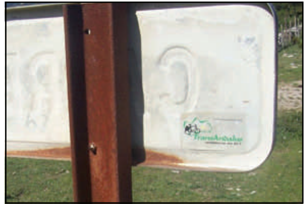
Señalización "low cost": pegata en una señal
